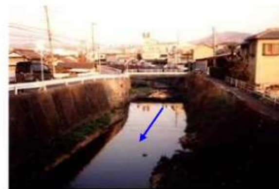
大乘川（国道166号上流付近）
