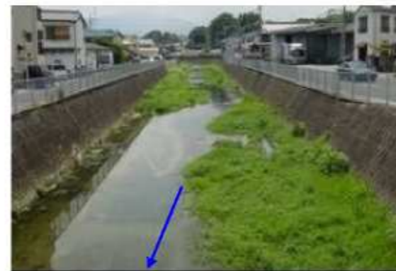
飛鳥川（逢坂橋上流付近）
