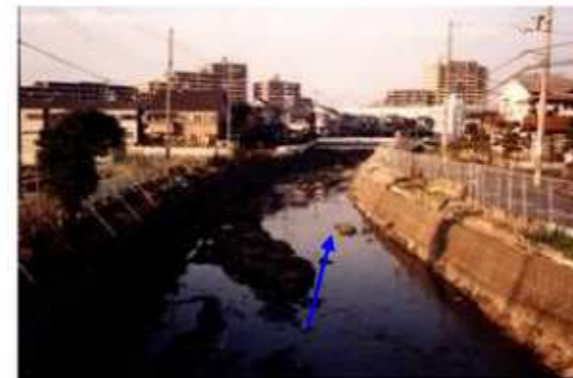
大乘川（西浦橋下流付近）
