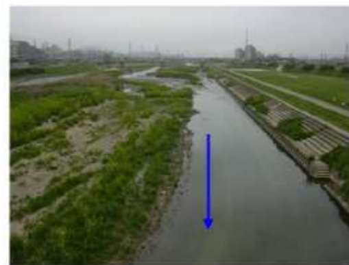
石川 (石川橋上流付近)
