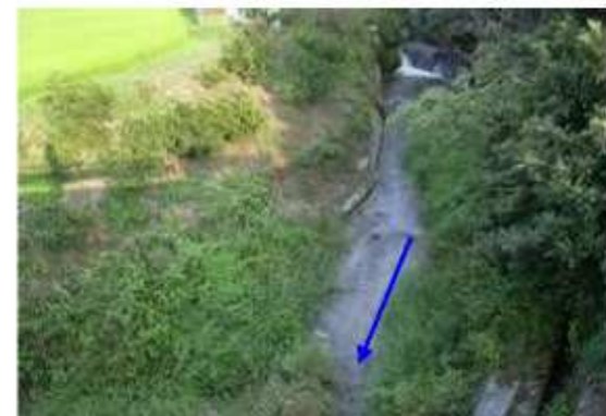
水越川（楠水橋上流付近）
