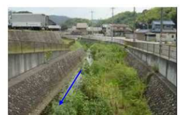
太井川（平成橋上流付近）
