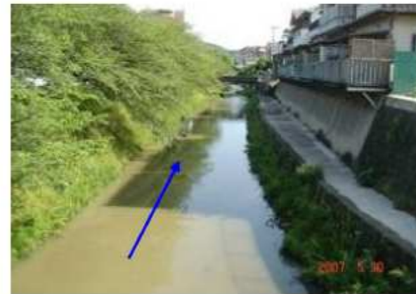
原川（府道原川橋下流付近）
