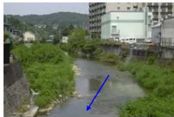
天見川（新前川橋下流付近）
