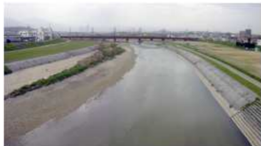
区間 A : 臥龍橋 (上流側) No. 3
