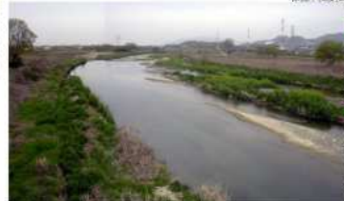
区間 A : 河南橋 (下流側) No. 4
