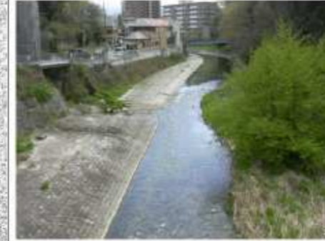
区間 B : 諸越橋 (上流側) No. 7
