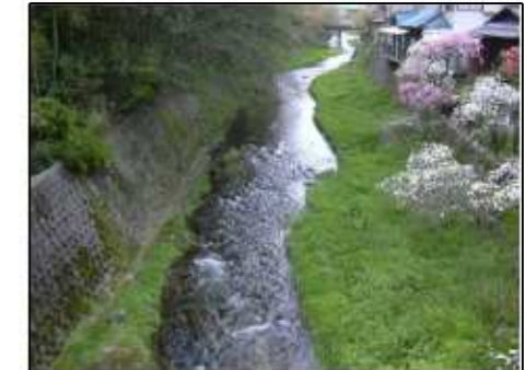
区間 C : 西条橋 (上流側) No. 8
