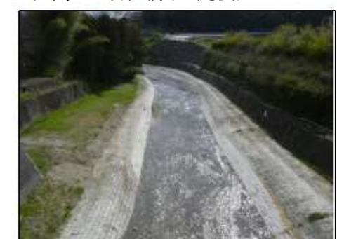
区間 C : 宮山橋 (上流側) No. 10
