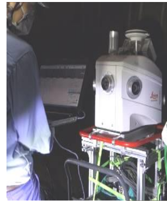
ICTを活用した 地下河川構造物の点検
