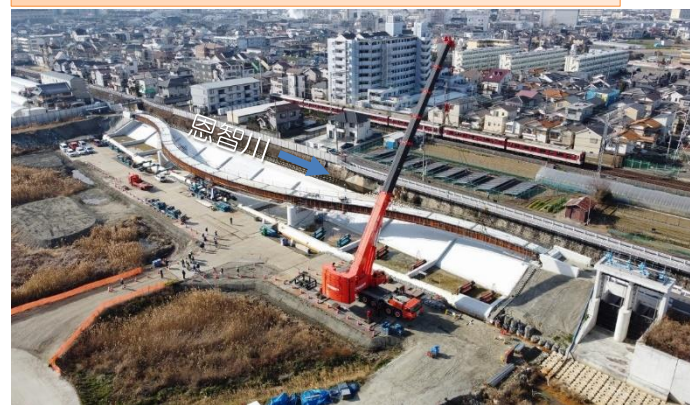
恩智川(法善寺)多目的遊水地施工状況
