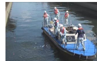
底質改善対策の 試行実施(薬剤散布)
