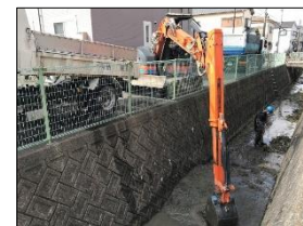
廿田川(にじゅうでんがわ) 底泥の浚渫(大東市)
