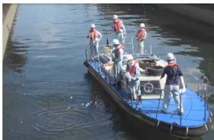
底質改善対策の試行実施(薬剤散布)
