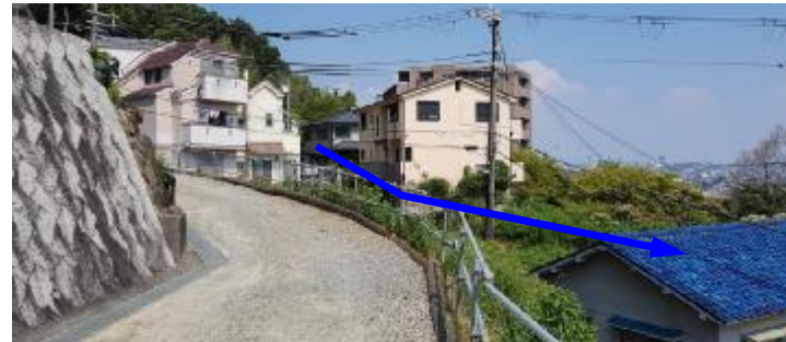
保全対象：人家
