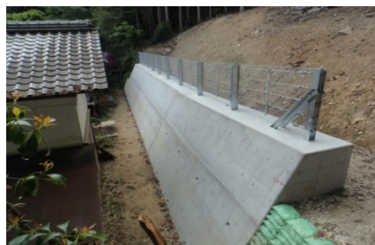
【急傾斜地崩壊防止工事】
