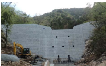
【砂防えん堤の事例】
