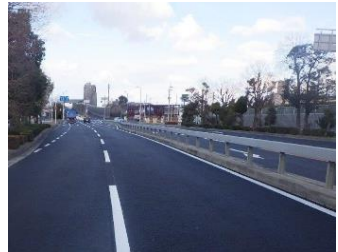
路面標示・舗装の補修（例）
