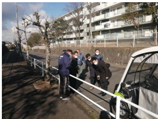
電磁誘導線工事立ち合い
