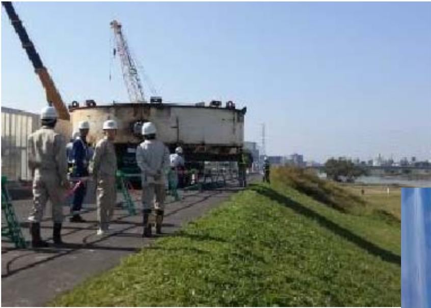
シールドマシンの最大部材である**旋回環 (74 t)**を国土交通省 (大和川河川事務所) の立会のもと、**時速1 km/h**の超低速運転で堤防道路上を運搬し、無事完了しました！
