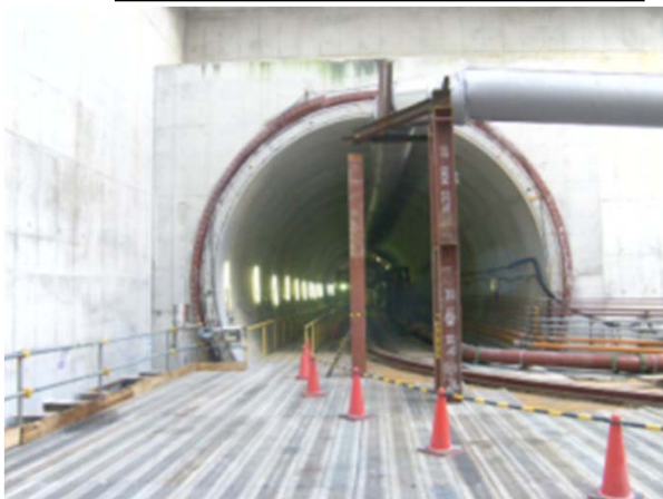
OFFランプ 掘進状況
