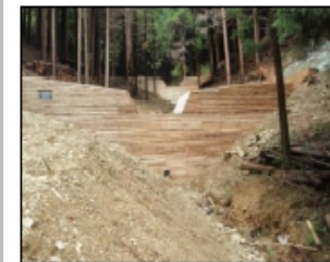
流木の被害を防ぐ治山ダム
