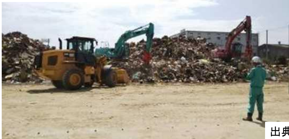
仮置き場の整備（重機）
