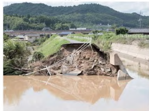
濁流により決壊した堤防
