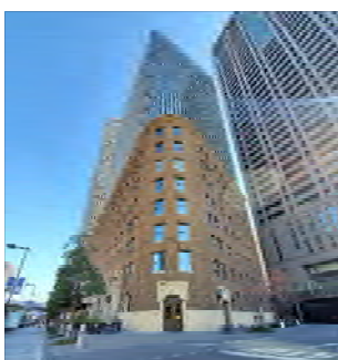
写真-3 ダイビル本館の建替
