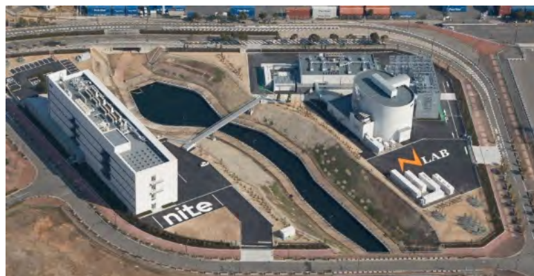
写真-5 大型蓄電池システム試験評価施設(NLAB)
