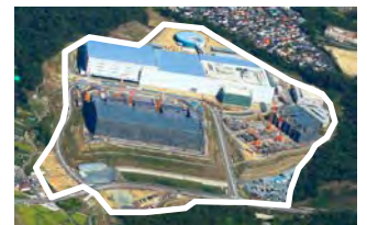
写真-2 山麓線エリア地区(R2.9)
