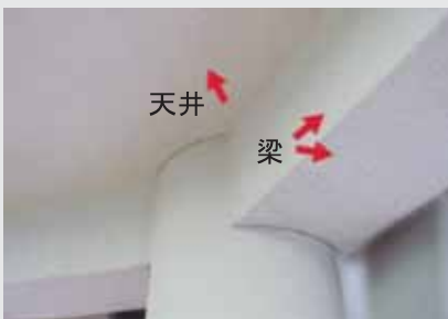
天井・梁仕上げ材
