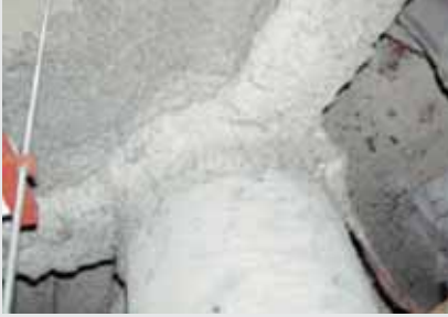
鉄骨耐火被覆
