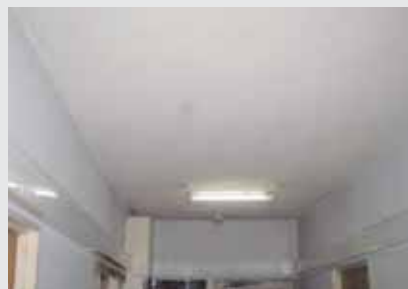
天井仕上げ材
