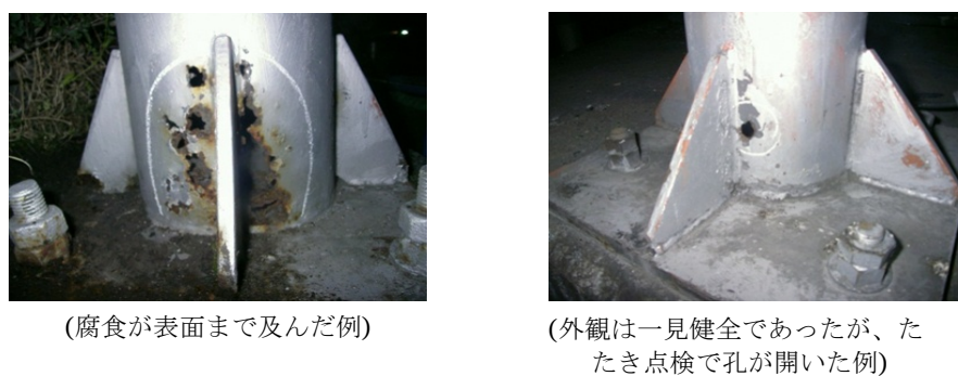
図5-3 照明柱、標識柱等の柱基部
