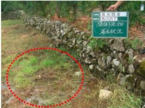
④ 染みだしやパイピングによる漏水
