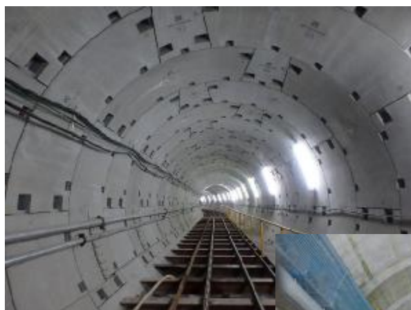
守口調節池 （シール発工事）
