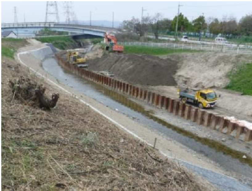
穂谷川改修工事（80mm対策）
