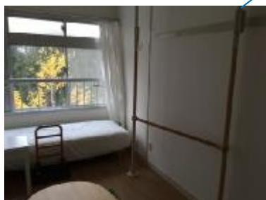
壁際に後付けの手すりを設置
