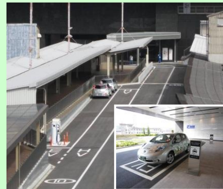
JR大阪駅EV/HVタクシー専用乗場(大)待機レーンと専用急速充電器(小)EVタクシー専用乗場
