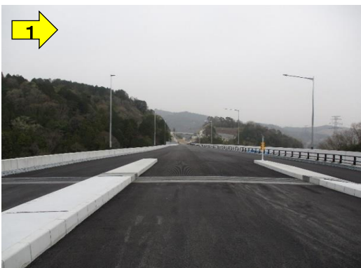
舗装工事が完了しました。 (ランプ部～橋梁部)
