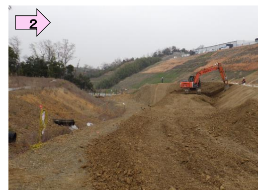
法面を整形しています。
