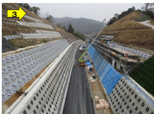
法面対策工事施工状況です。 (南北線より茨木亀岡線側)
