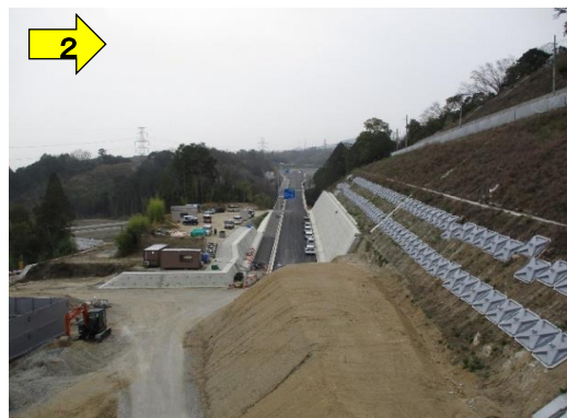
大岩南北線より千堤寺IC側の現況です。
