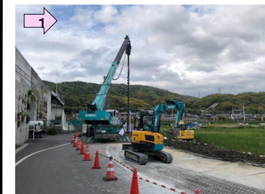
鋼矢板打設に向け先行掘削しています。
