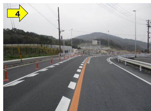
交差点改良工事が完了しました。 (茨木亀岡線交差点部)
