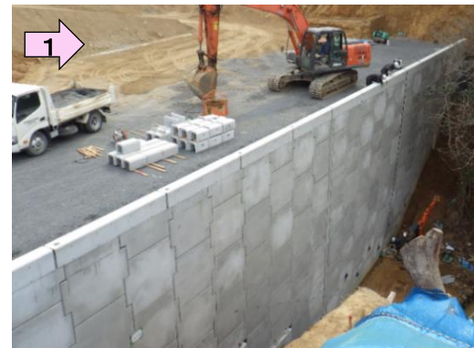
補強土壁が完了しました。
