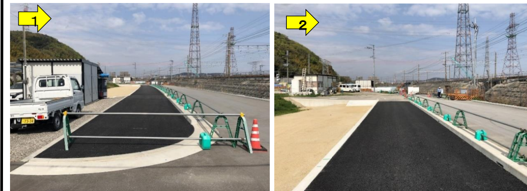
歩道改良工事が完了しました。 (高槻→京都)
