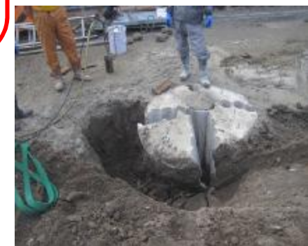
騒音・振動低減工法による撤去
