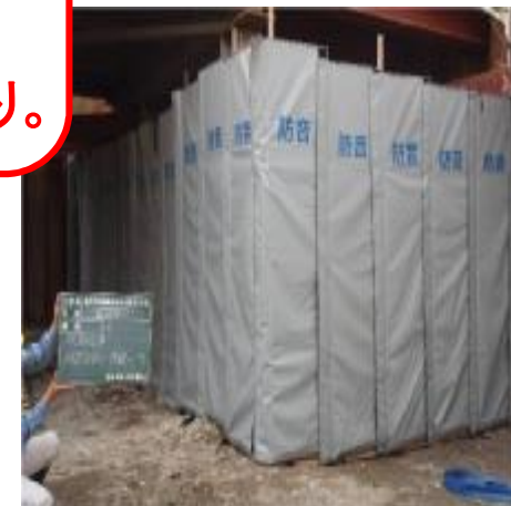
防音シートによる騒音対策
