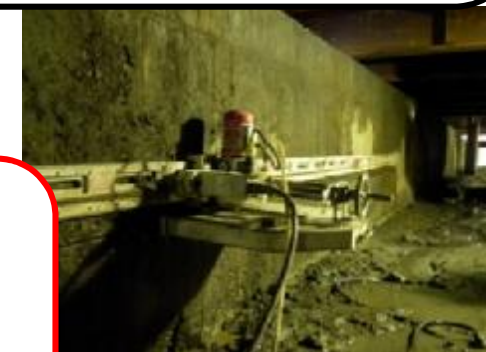
ワイヤーソーによる取壊し
