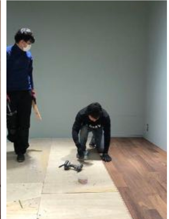
個室床フローリング貼り
