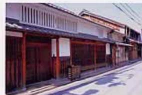
57 本町 旧紀州街道沿いのまちなみ (岸和田市)
