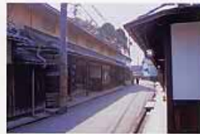
43 長野町 旧高野街道沿いのまちなみ (河内長野市)
