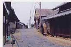
39 旧暗峠越奈良街道 暗峠のまちなみ (東大阪市)
