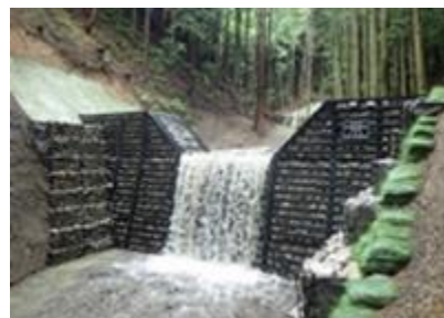
治山ダム（高槻市成合地区）【完成】
