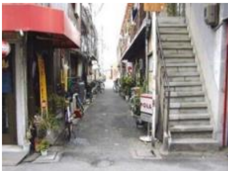
地区公共施設等の整備例（整備前）
