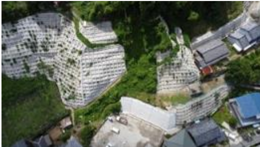
急傾斜崩壊対策事業（柏原市 畑(4)地区）
