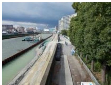
一級河川 六軒家川 防潮堤補強【完成】
