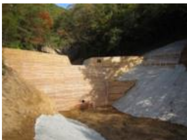
治山ダム（能勢町山辺地区）【完成】
