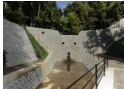
土石流対策事業（箕面市 宮谷砂防えん堤）
