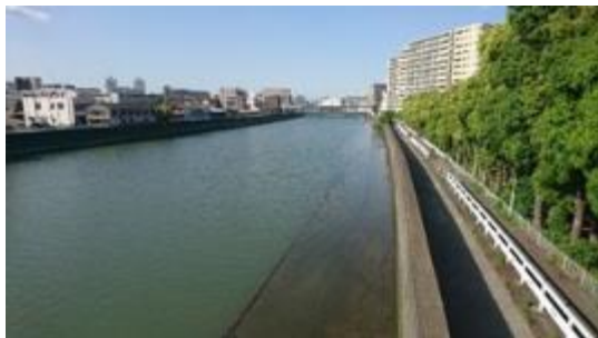
一級河川 六軒家川 防潮堤補強【工事中】
