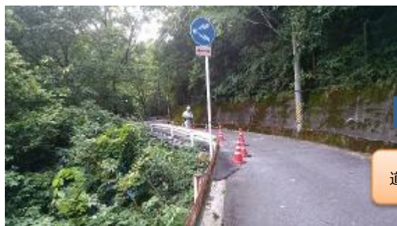
河内長野かつらぎ線（河内長野市）【対策前】
