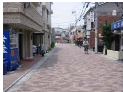
地区公共施設等の整備例（整備後）
