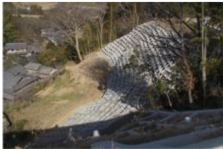
急傾斜崩壊対策事業（千早赤阪村）【工事中】
