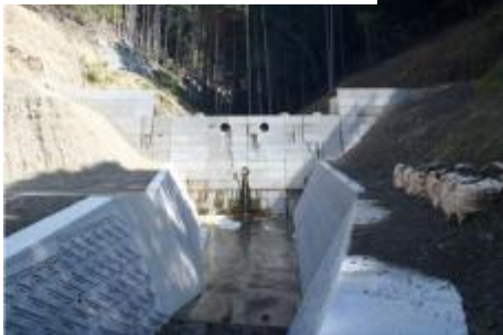
砂防事業（豊能町）【工事中】
