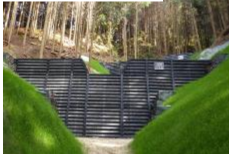
治山ダム（枚方市）【完成】
