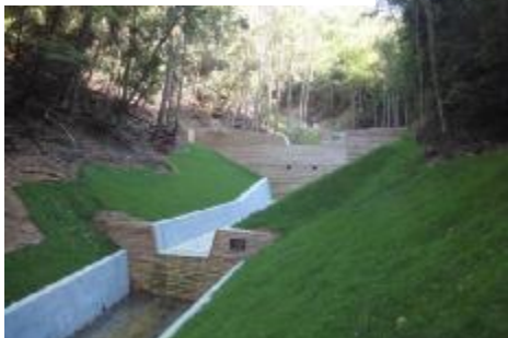
治山ダム（能勢町）【完成】
