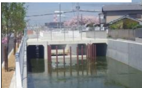
芦田川二層河川区間 (高石市)【完成】
