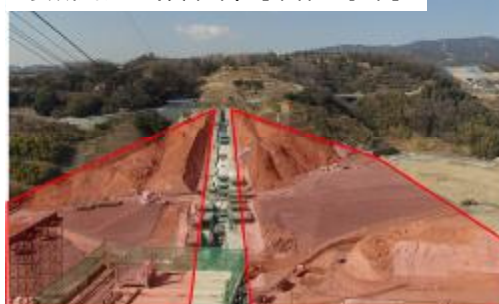
安威川ダム (茨木市)【本体工事中】
