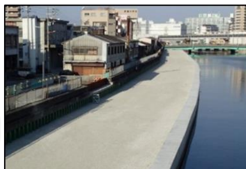
一級河川 六軒家川 防潮堤補強【対策後】
