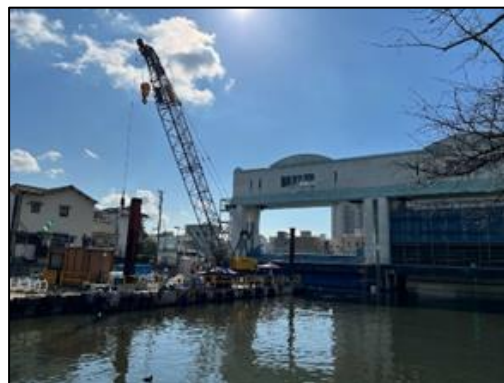
城北寝屋川口水門耐震補強工事
