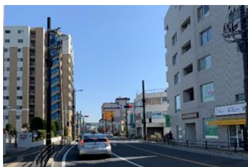
国道 176 号無電柱化【対策後】
