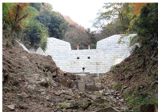
土石流対策事業（一の谷砂防堰堤）
