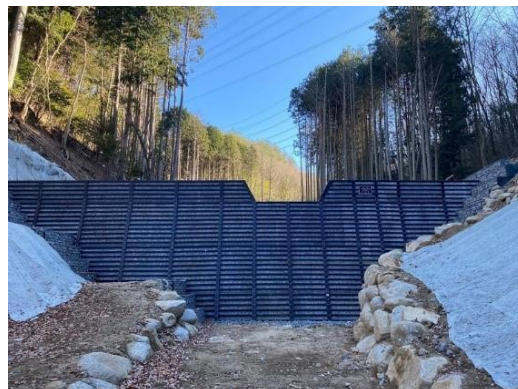
治山ダム（豊能町木代地区）
