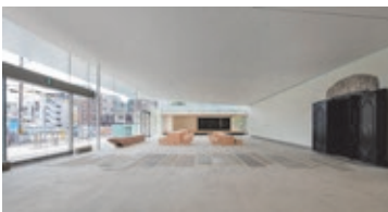
昔ながらの知恵である土間の気化熱を利用した涼の工夫
