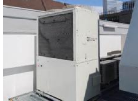
非常時にGHPに切り替えて収蔵庫(二重壁)空調のバックアップ
