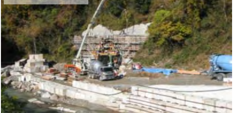
下流側坑口の様子
