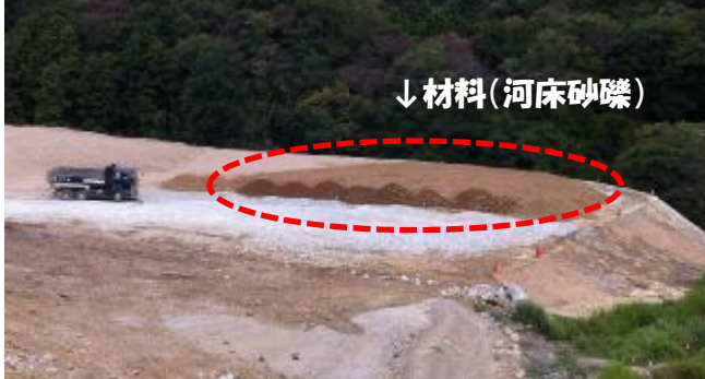
上流仮締切工の材料採取状況
