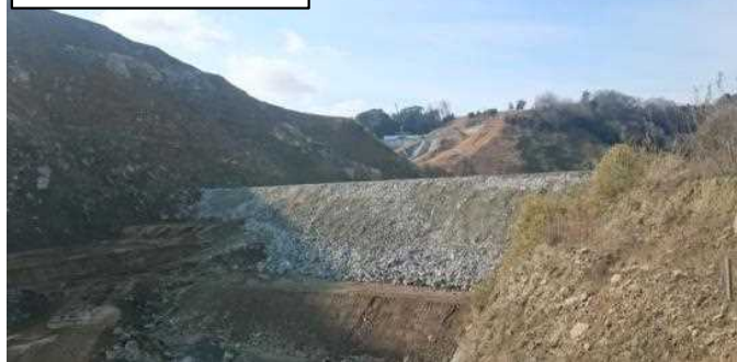
仮締切堤完成!!
