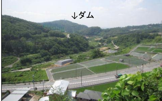
⑤車作代替宅地より貯水池を望む
