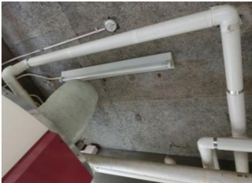
ボイラー上部
