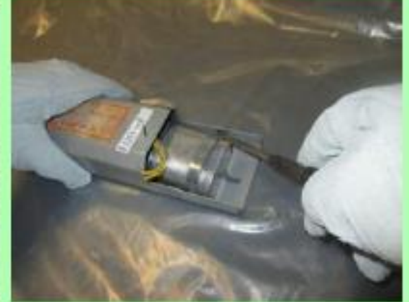
コンデンサの 取り外し作業
