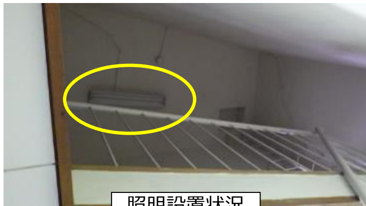
照明設置状況
