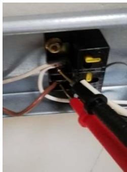
※クランプメーターのピンプラグを端子台に接続して測定
