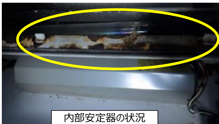
トンネルナトリウム灯（崩落寸前）
