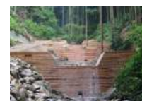
治山ダムの整備
