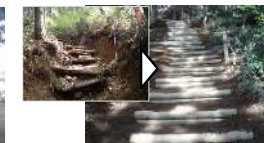
歩道の安全対策
