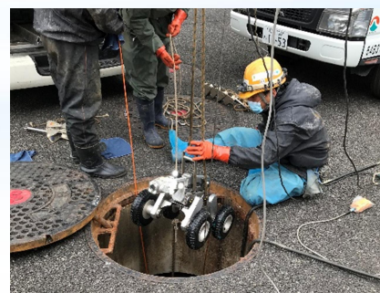
詳細点検状況 (TVカメラ調査)
