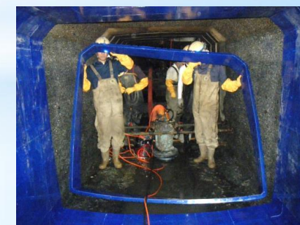
対策実施状況 (管更生工法)
