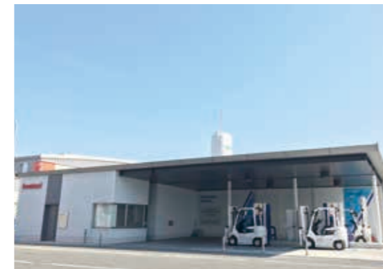
産業車両用の水素供給施設(平成29年3月開所)
