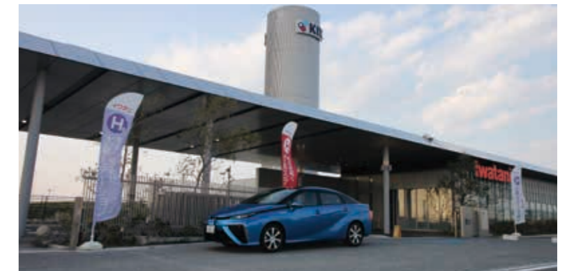
イワタニ水素ステーション関西国際空港(平成28年1月開所)
