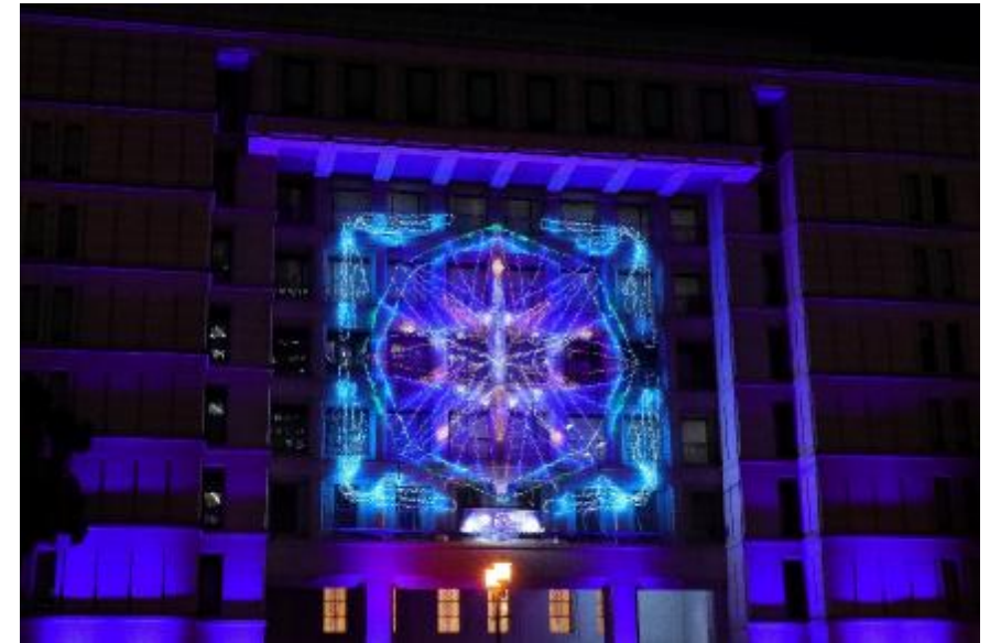
大阪市庁舎正面イルミネーションファサード
