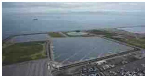
泉大津大規模太陽光発電施設
