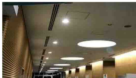
区役所フロアのLED照明
