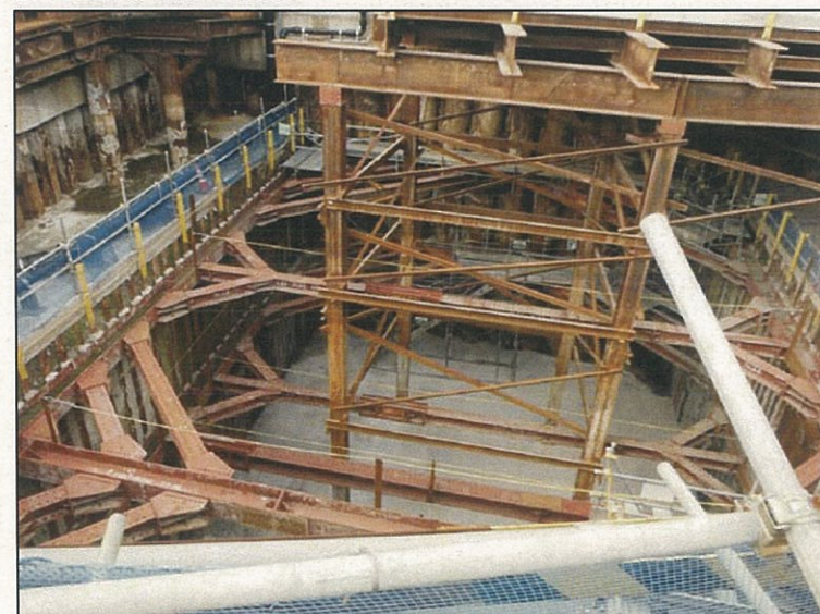
② 最下流立坑部
