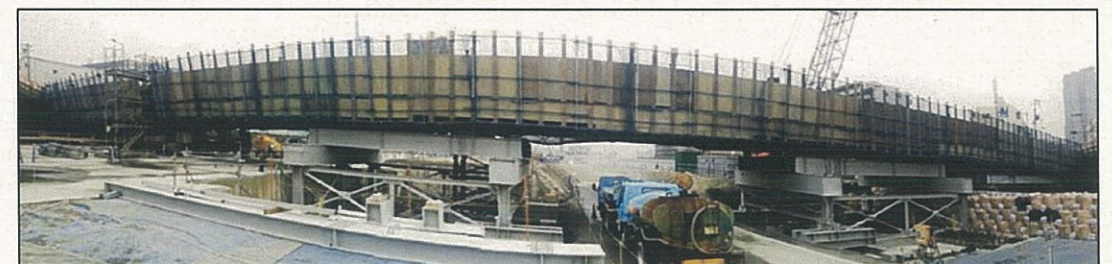
⑤ 上流より
