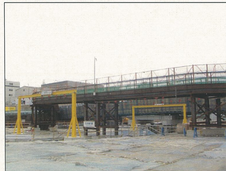
⑤' 北港新橋上流より
