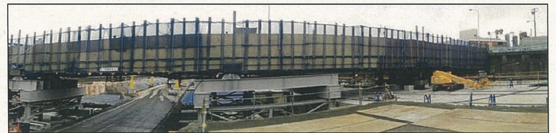
④ 下流より
