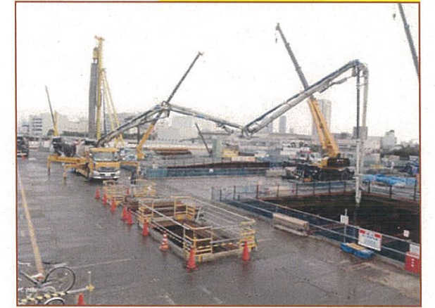
写真④B2F壁(1 ロッド)打設完了
