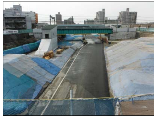
⑧ 埋戻、仮置中（阪神電鉄交差部）
