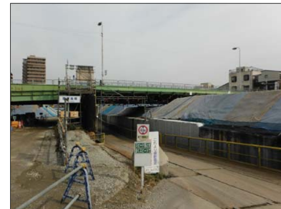
⑥ 埋戻、仮置中（恩貴島橋直下）
