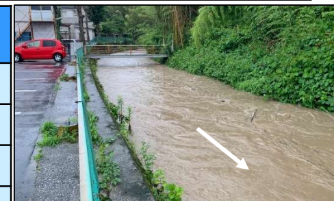
R5.6月 雨山川状況写真
