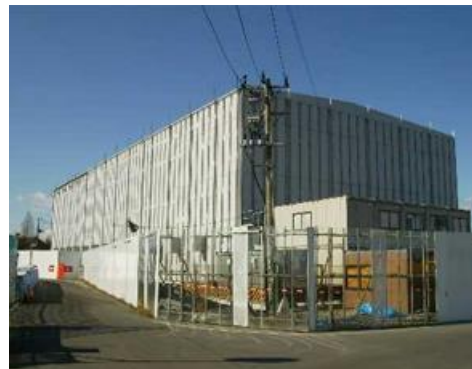
施工事例 (出典：防音設備協会HP)
