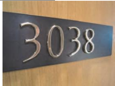
室番号の浮き彫り表示の例
