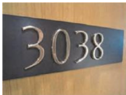
室番号の浮き彫り表示の例
