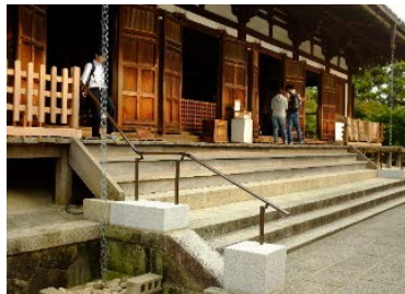
図3 仮設の手すり
