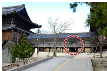
図4 回廊の裏側に設置されたエレベーター
