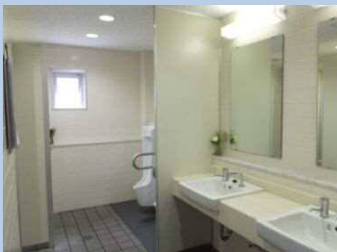
トイレ改修施工後
