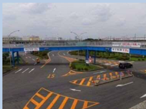
歩道橋塗装施工後
