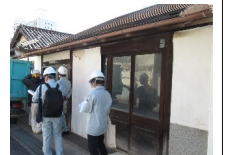
解体工事現場指導(建設リサイクルパトロール)
