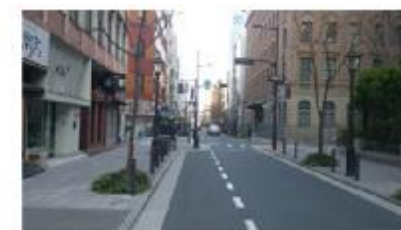
電線が地中化された二休橋の様子
